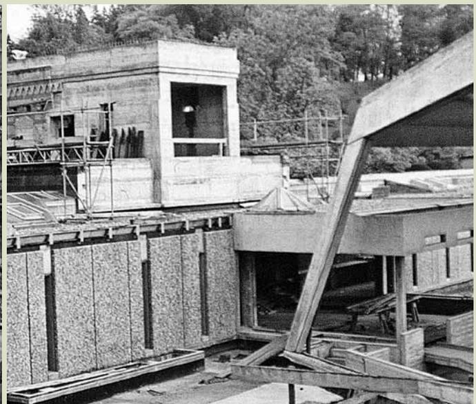
Die Baugrube und das Fundament: Über 10.000 Kubikmeter Erde wurden für das Aquariengebäude ausgehoben, das wegen des schlammigen Bodens auf 250 Betonpfählen steht (L.). Das Haus nimmt Gestalt an: Schon sind die späteren Außenwände aus Waschbeton und der kubische Rahmen der Krokodilhalle in der Mitte des lang gestreckten Baus zu erkennen (M.).
